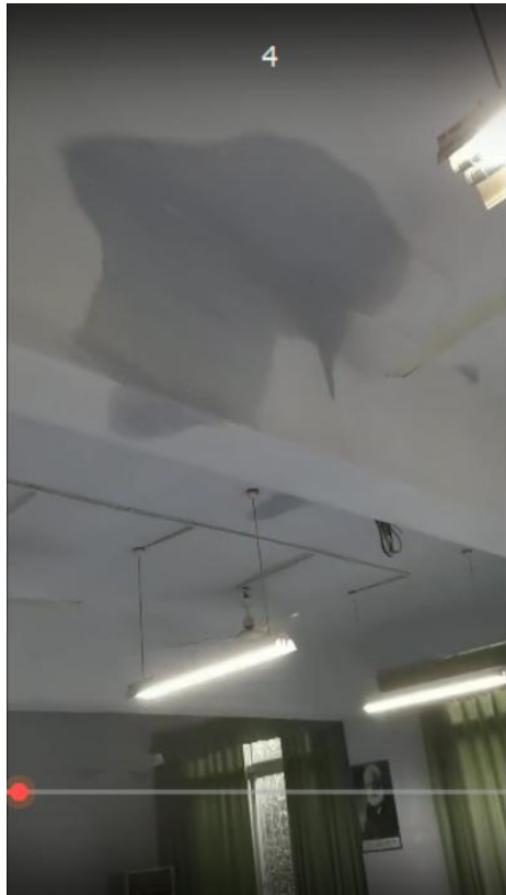
实训室 209 因上层漏水导致教学设备进水
